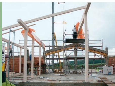
Zimmerei Lauchs im Einsatz
