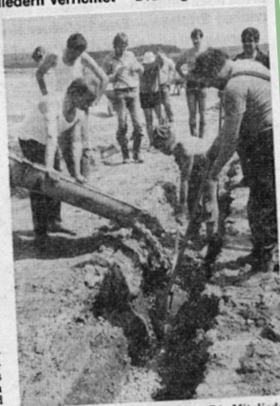
Tennisplatzbau beim TSV Rohr: Die Mitglieder helfen tatkräftig zusammen. Foto: Privat
