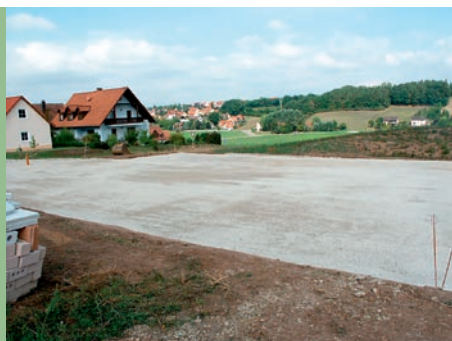
Pflastern des Parkplatzes
