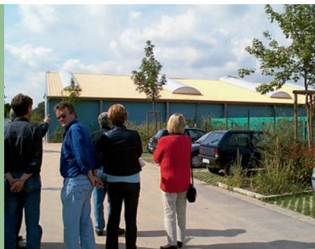
Besichtigung der Tennishalle in Biblis
